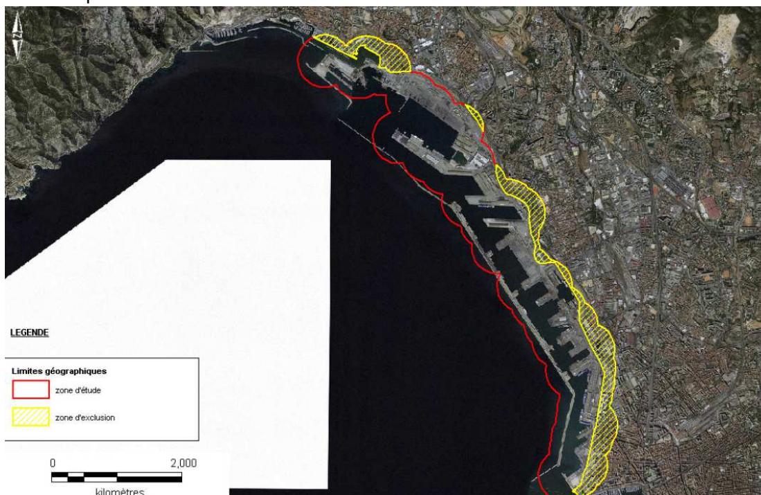
Ortho-photo du Grand Port Maritime de Marseille (GPMM) présentant la zone d'étude du RSI. La zone hachurée en jaune représente la zone située en dehors des limites administratives de l'aéroport.
